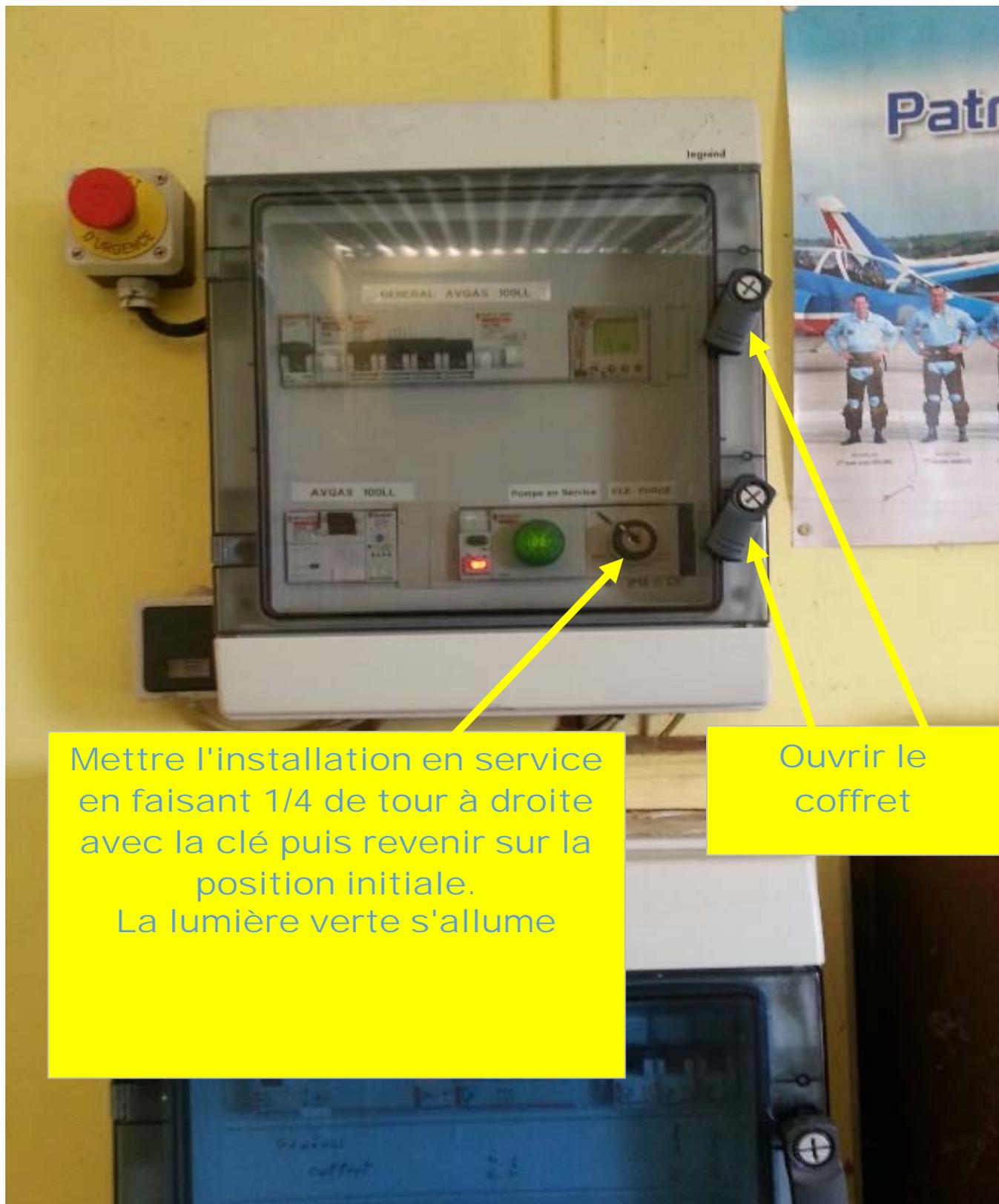
Mettre l'installation en service en faisant 1/4 de tour à droite avec la clé puis revenir sur la position initiale.
